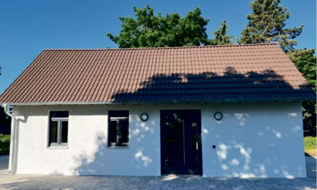
Die ehemalige Aussegnungshalle wurde zum „Kleinen Kulturhaus“, einem Ort für Treffen und Veranstaltungen.
