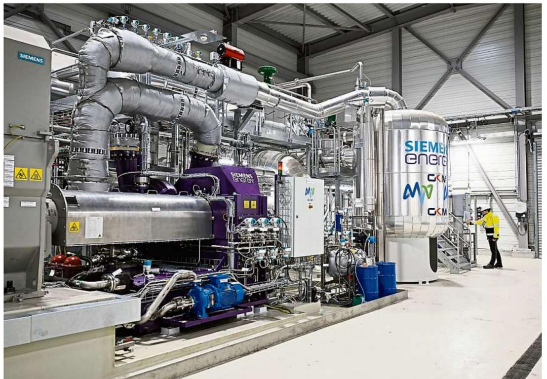
Ein Mitarbeiter steht auf dem Gelände des Großkraftwerks Mannheim an einer Flusswärmepumpe.
