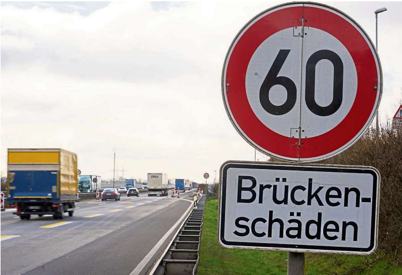
Allein Tausende Brücken müssten in den nächsten Jahren dringend saniert werden.
