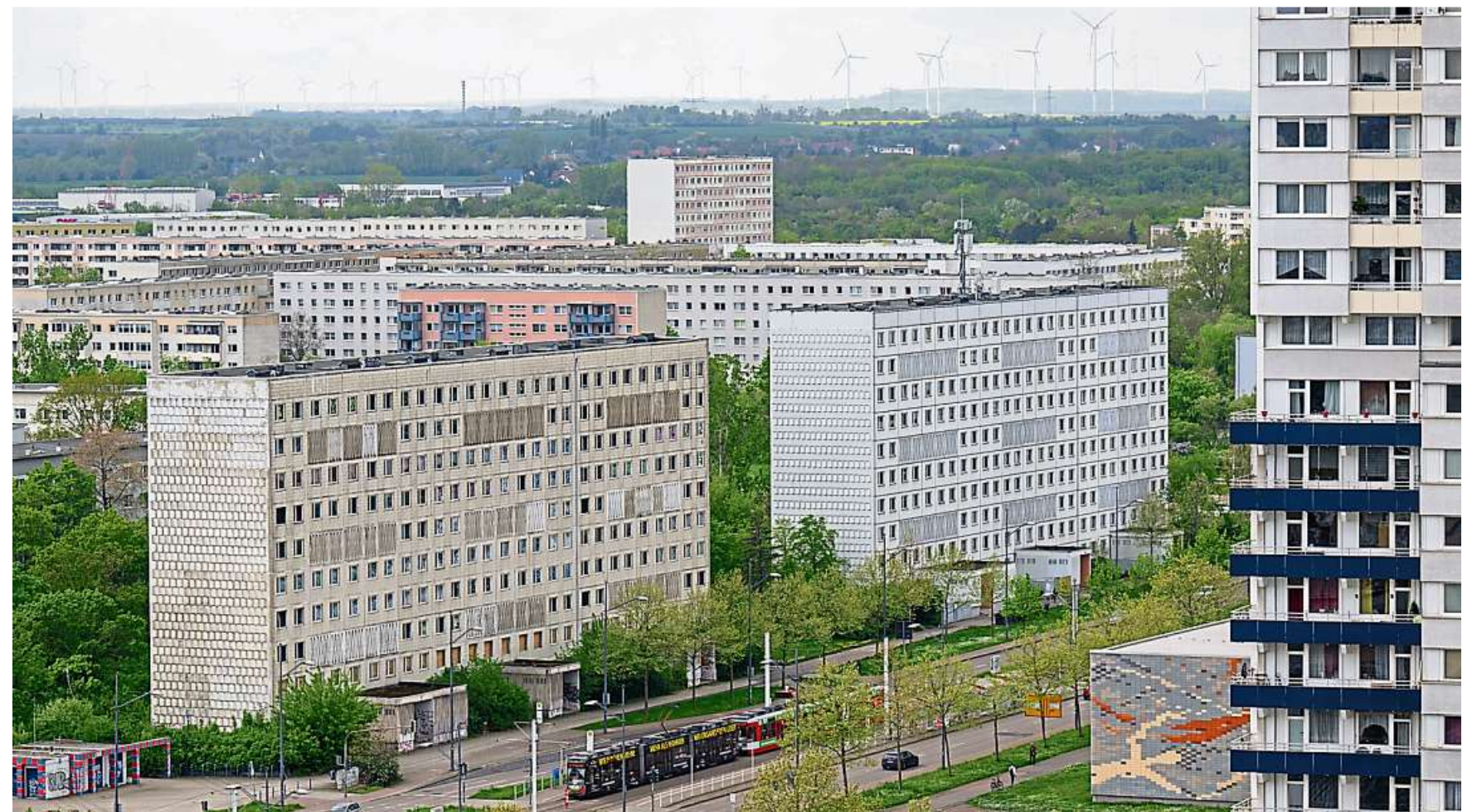
Blick auf einen leerstehenden DDR-Wohnblock (links) im Plattenbaugebiet Halle-Neustadt. Der Block gilt als Baudenkmal.
