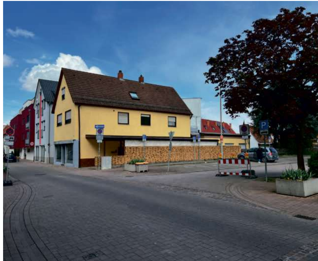
Ab der Hausnummer 23 in der Hauptstraße bis zum Kreuzplatz wird die Hauptstraße ab Herbst ausgebaut. Fotos: tgb
