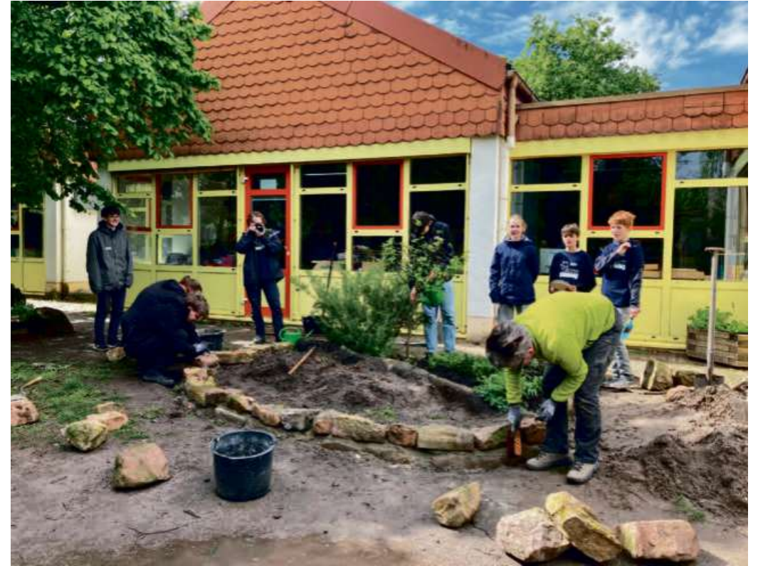
Ein Hochbeet entsteht.
