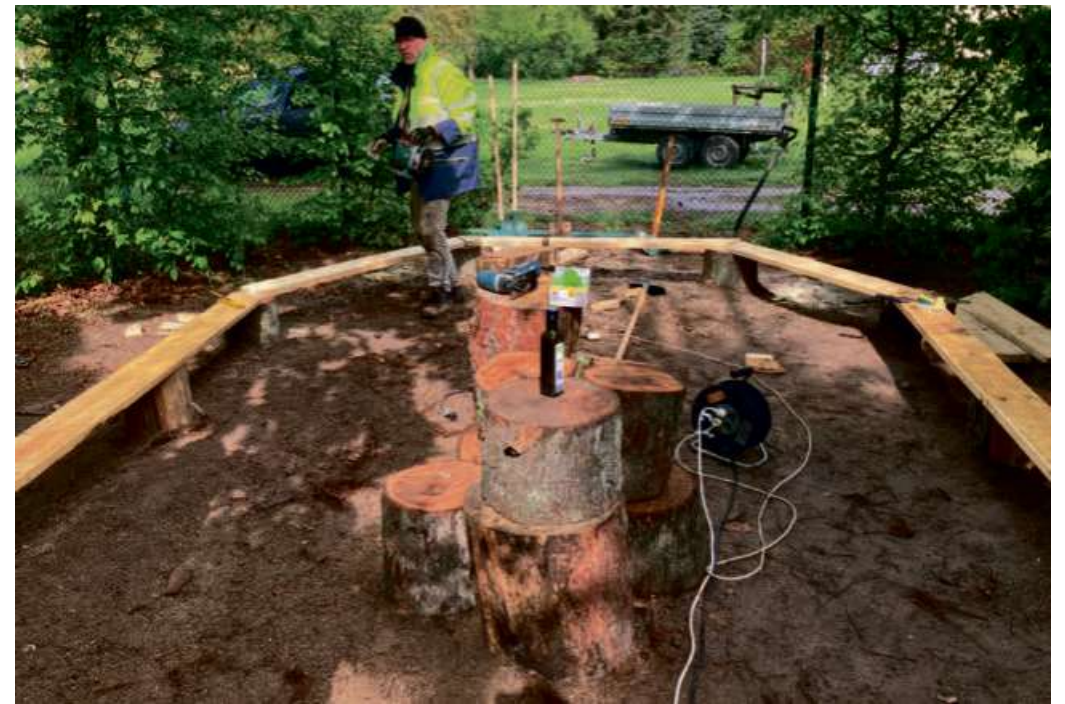
Der Bauwagen ist weg – ein gemütlicher Picknickplatz ist in Arbeit.
